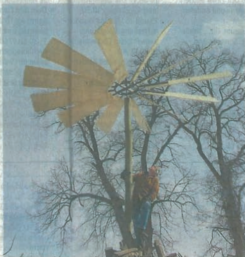
Klaus Schuhmann beim Bau der ersten Feuermühle.
